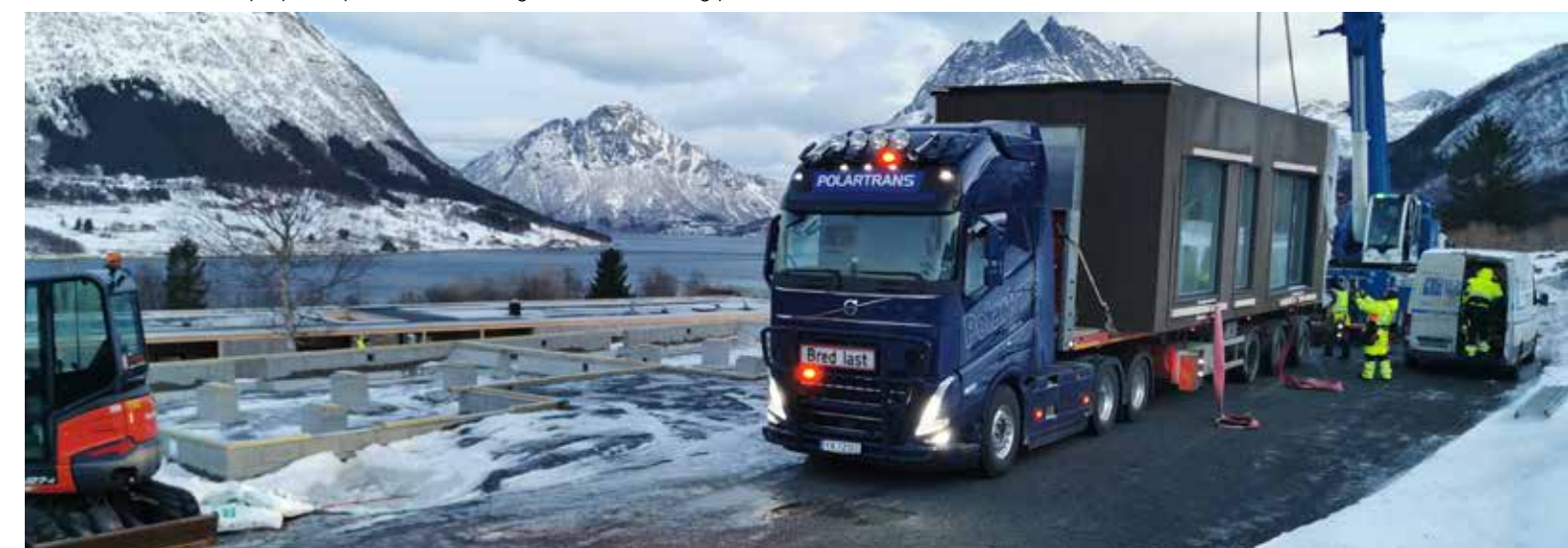
Første modul på plass på Sandmelan og klar til montering på fundament
