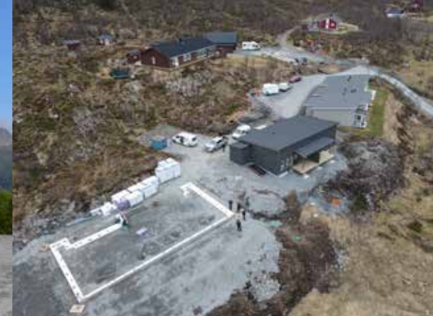
Bygg ferdig montert i Småskogan
