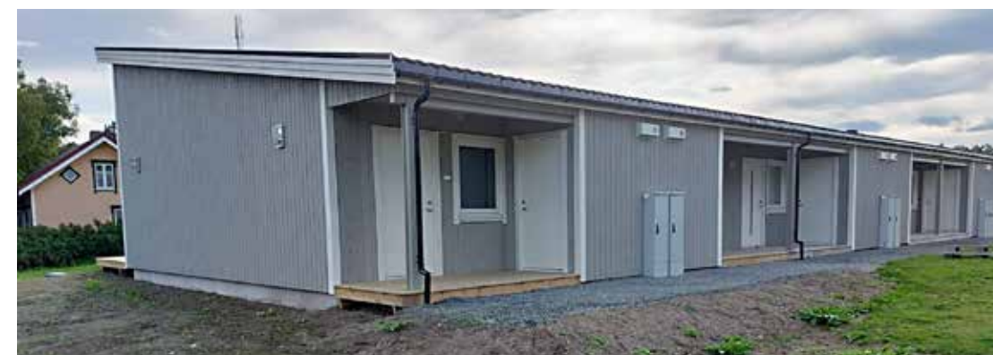
Fasade påbygg Lovund.
